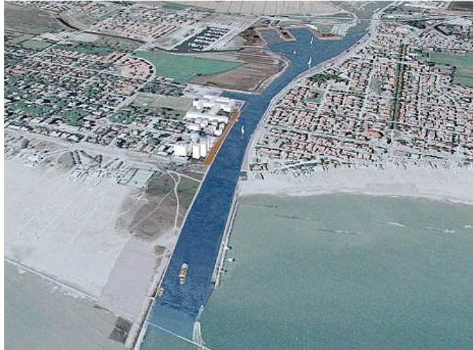
I lavori per l'idrovia a Porto Garibaldi
